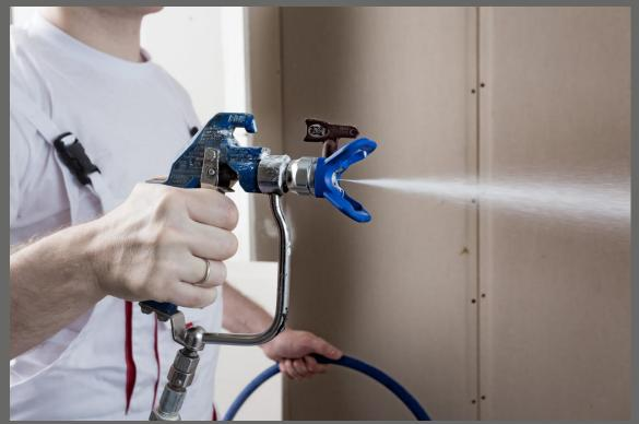
Шпатлёвка для механизированных работ Danogips ProSpray
